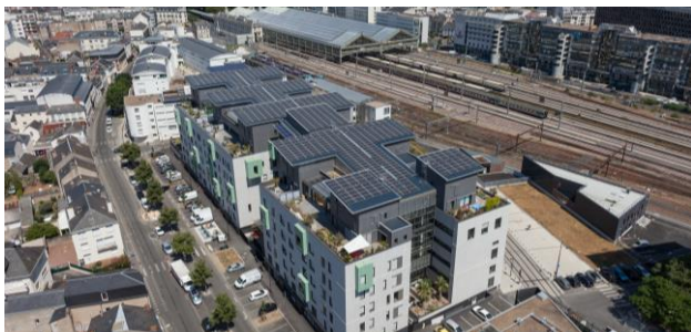
La Nef (37) – Centrale solaire de 234 kWc dont 134 kWc en autoconsommation
