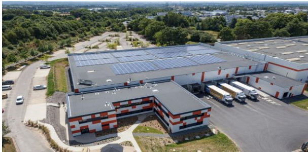
Biocoop (35) – Centrale solaire de 300 kWc en autoconsommation
