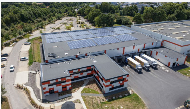
Biocoop (Melesse - 35) - Toiture solaire 300 kWc en autoconsommation
