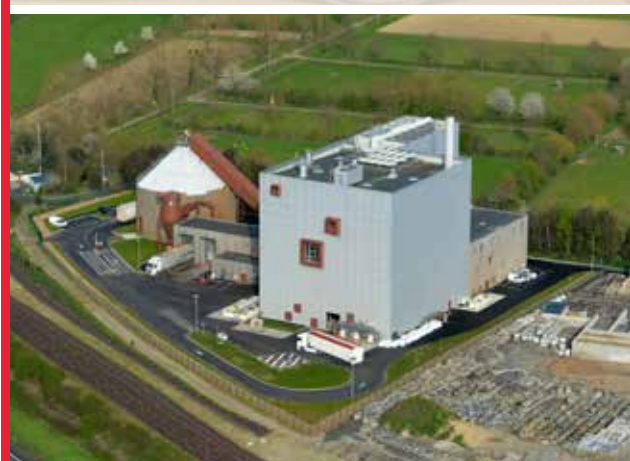
Chaufferie CRE Dalkia - Rennes (35)
