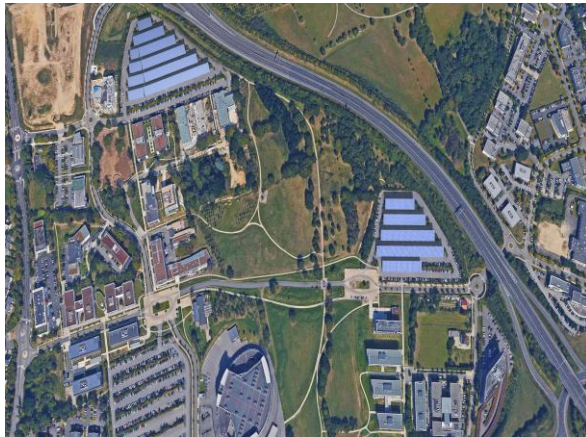
Ombrières photovoltaïques – Zénith de Nantes (44)
